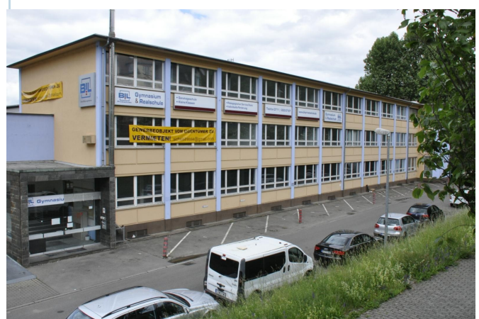
Dieses Gebäude in der Sichelstraße in Bad Cannstatt steht schon seit Langem leer.
