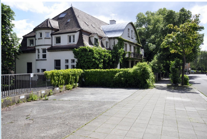
Diese Villa in der Rommelstraße im Hallschlag steht seit Jahren leer.
